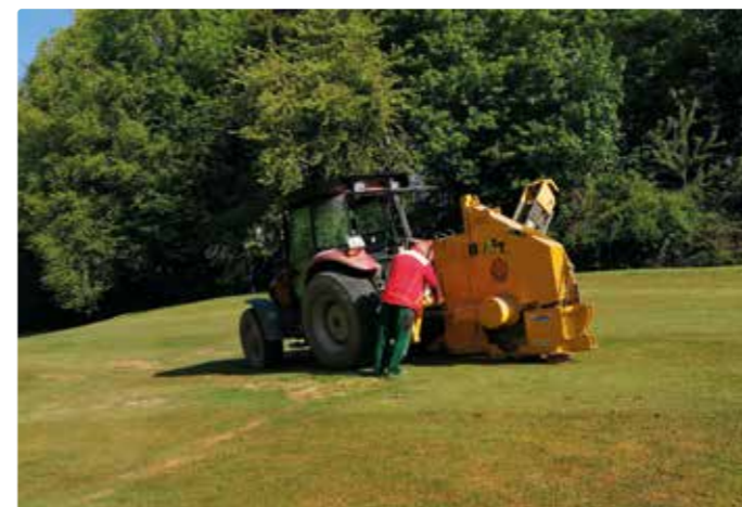
Fräsen von Drainagegräben an Spielbahn 12 Ostplatz
